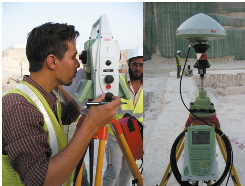
Le système des "points GNSS actifs" en œuvre pour la tour CMA de Riyad, Arabie Saoudite
